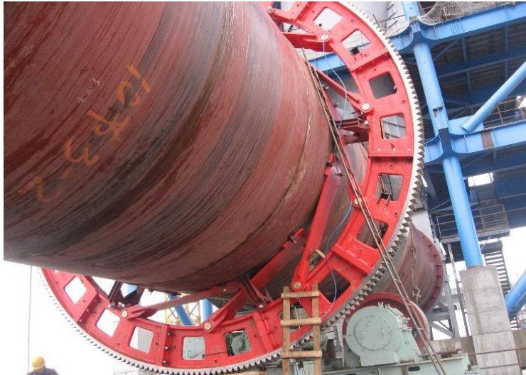
图5 巴基斯坦 \phi 5\text{m} \times 72\text{m} 回转窑的大齿圈现场安装
