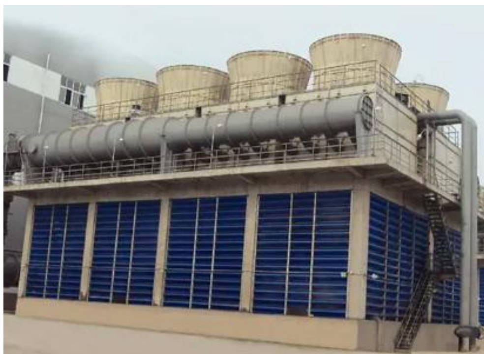
图 5 蒸发式凝汽器
