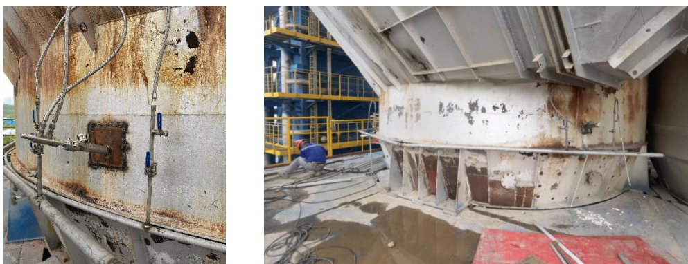
图 3 改造后现场照片（左一：喷射模块； 右一：C5 锥部喷枪布置）
